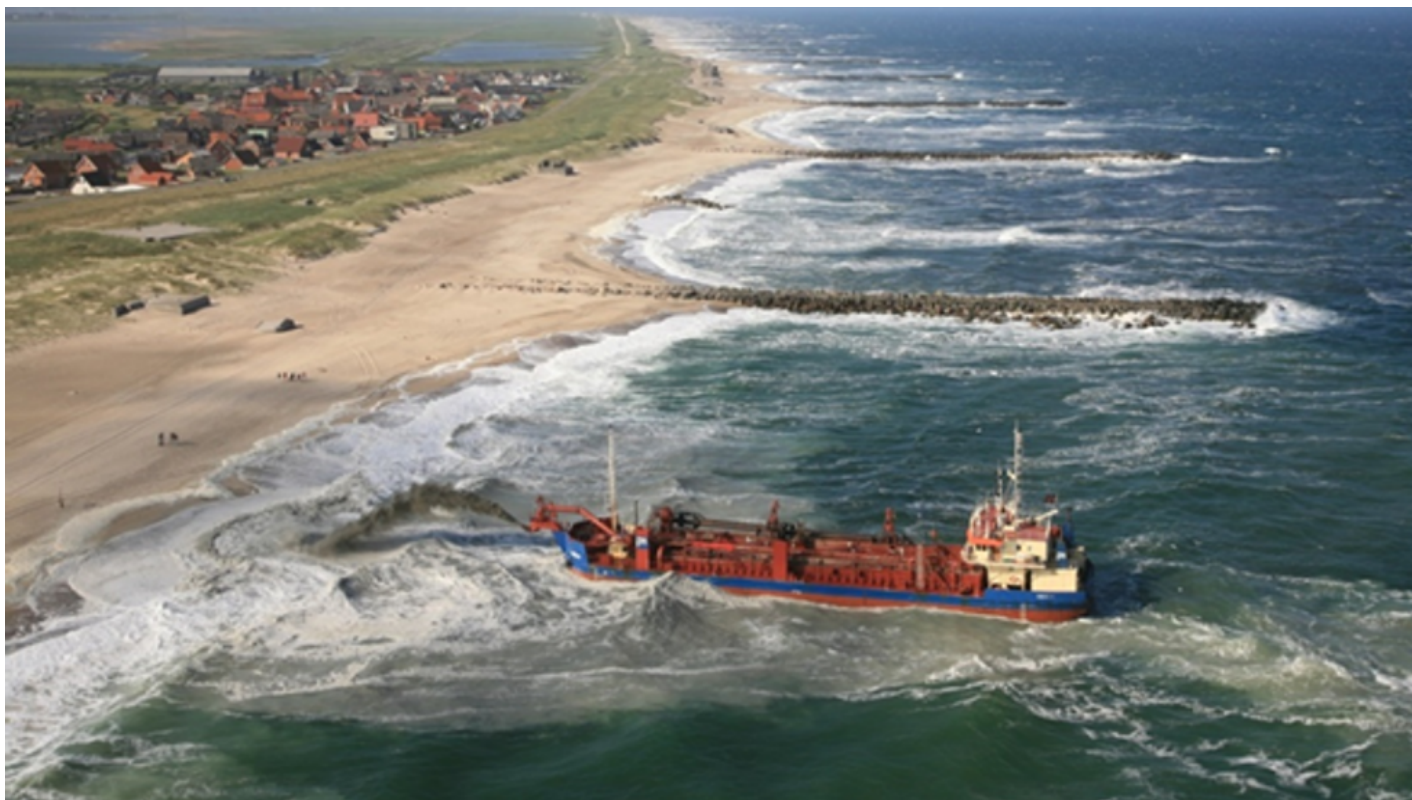
På den yderste vestkyst bliver der brugt mange flere millioner på sandfodring. Nogle steder pumpes sandet ind på stranden. Foto: Kystdirektoratet
