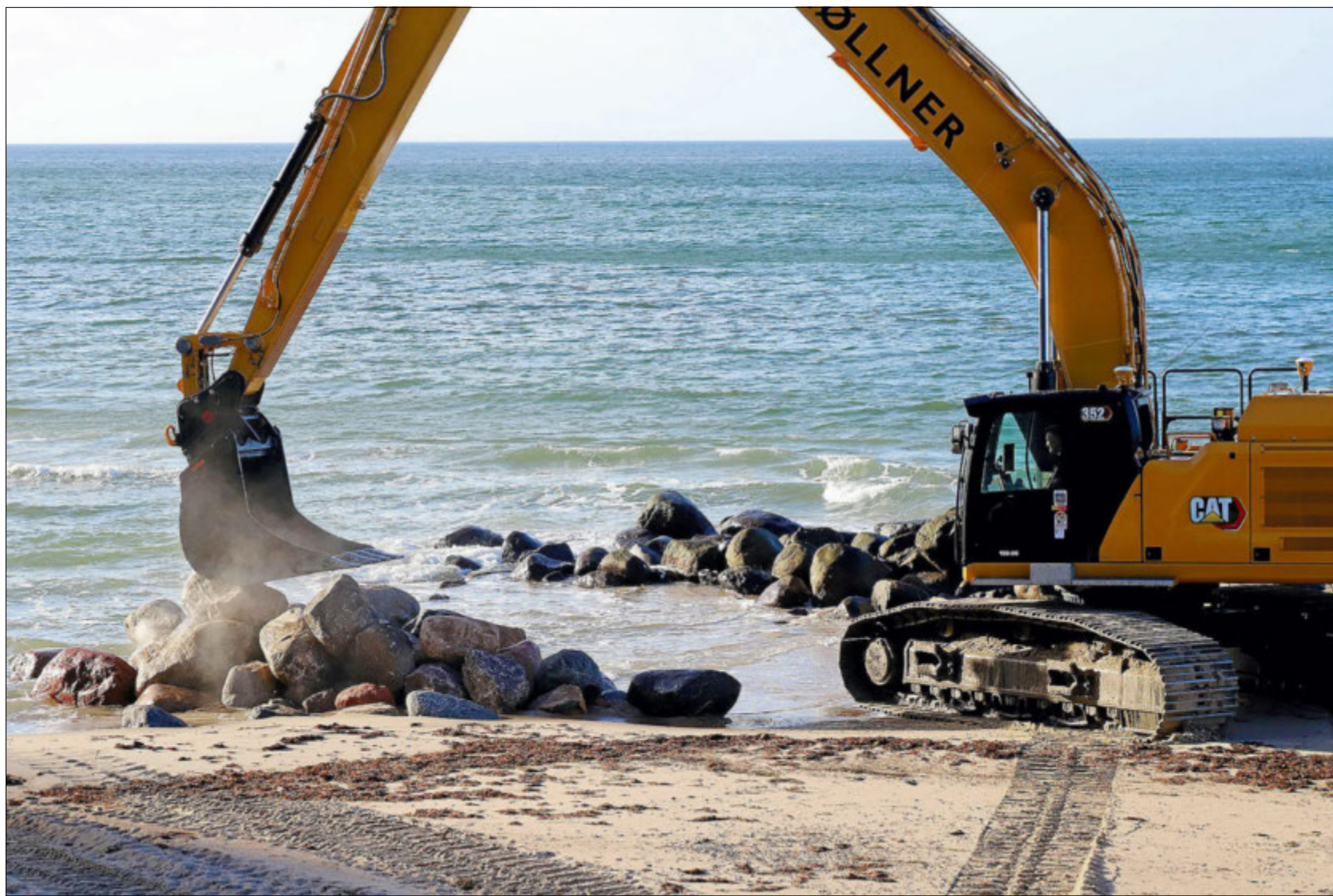
Der er fuld gang i arbejdet. Foto: Allan Nørregaard
